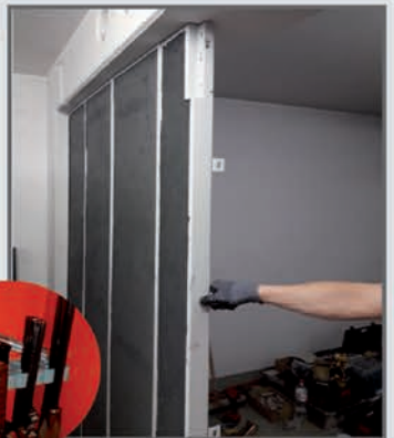
Aufrüstung von Räumen zu gleichwertigen Waffenräumen
