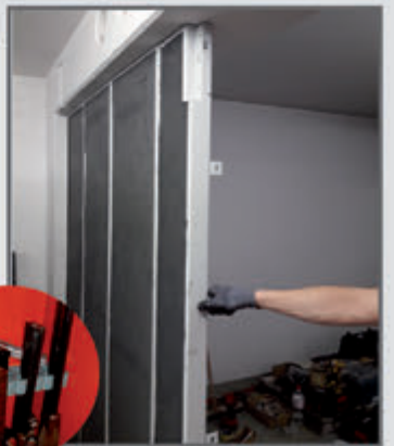
Aufrüstung von Räumen zu gleichwertigen Waffenräumen
